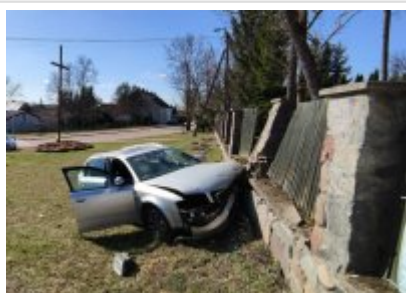
Miejsce zdarzenia drogowego
