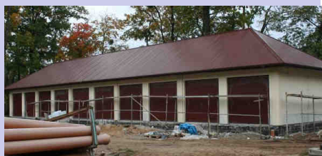
2008r. - budowa garaży.
