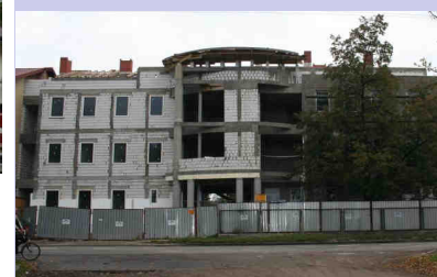
2008r. - budowa nowej siedziby KPP w Szczycie.
