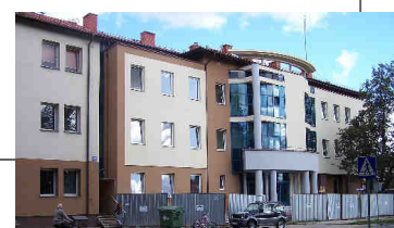
2009r. – Budowa nowej siedziby KPP w Szczytnie
