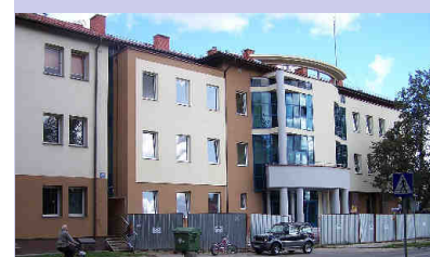
2009r. - budowa nowej siedziby KPP w Szczycie.
