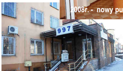
2008r. - siedziba KPP w Elku po remoncie.
